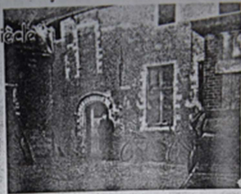
ENTREE de la maison, partiellement détruite où naquit Régis. Vue prise de la cour intérieure.
