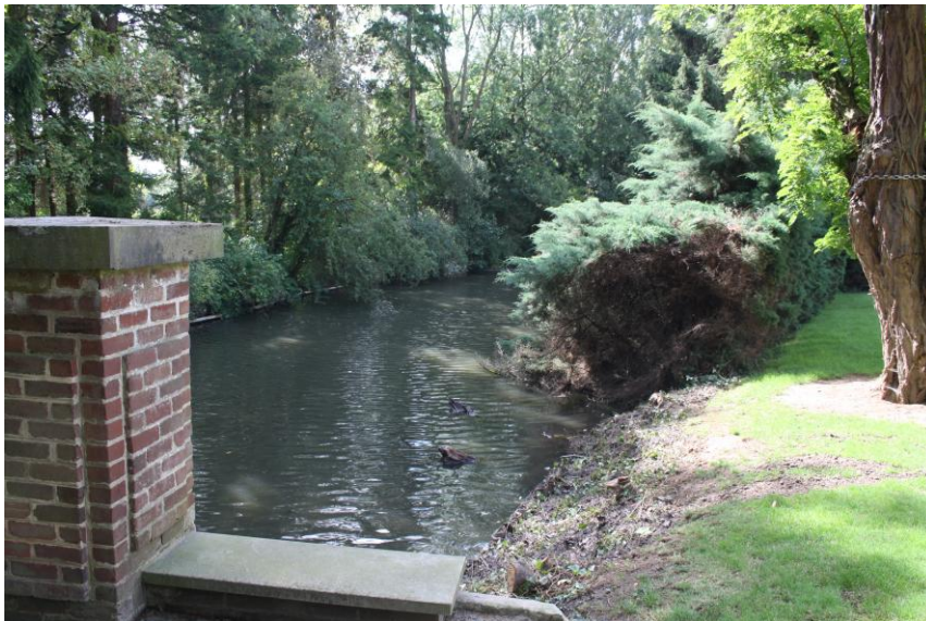
Stenen brug met sluitingshek over de omwallinggracht
