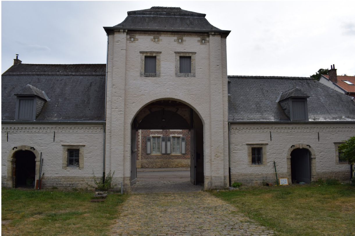
De inrijpoort van de pastorie aan de binnenkant/ Porte d'entrée du presbytère vu de l'intérieur
