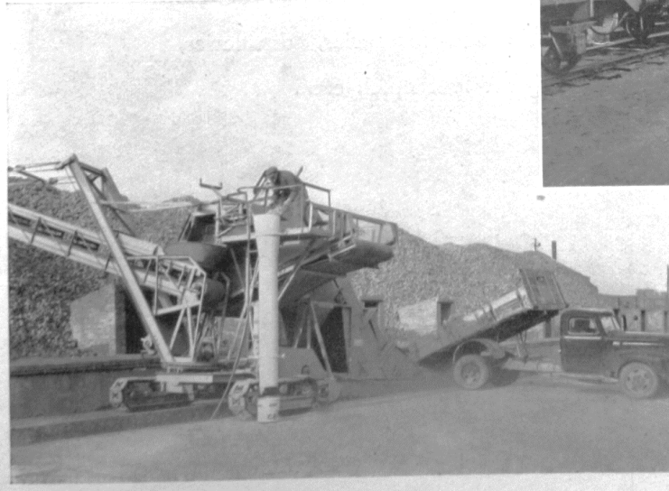
Déchargement de camions par appareil « Silver »
