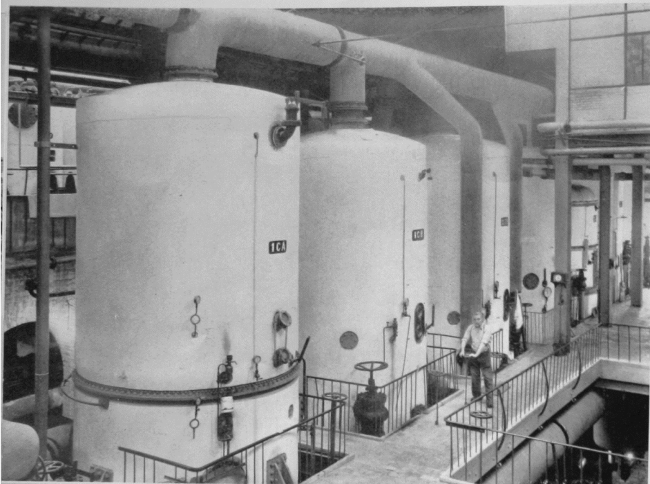
Appareil d'évaporation à multiple effet
