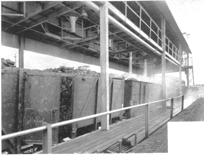
Déchargement hydraulique des wagons de betteraves
