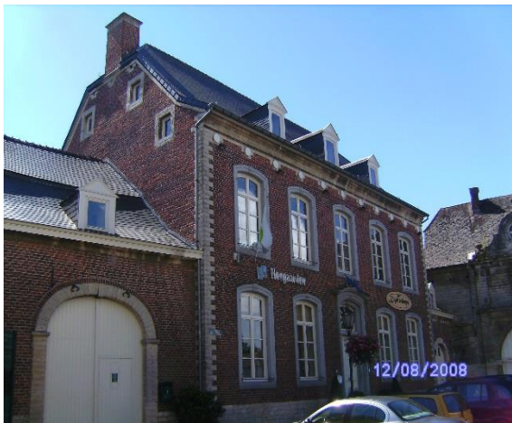
Jean Baptist Dumont woonde in het ouderlijk huis op de Houtmarkt, het voormalige Kapittelhuis; Was progressist en al politiek actief onder Franse Bewind
