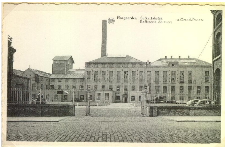
vooraanzicht van de suikerfabriek in de Nieuwstraat, hier verkeerdelijk Grand Pont genoemd, Helemaal links vooraan een tip van het gebouw dat ook te zien is op de prentkaart van p.12
