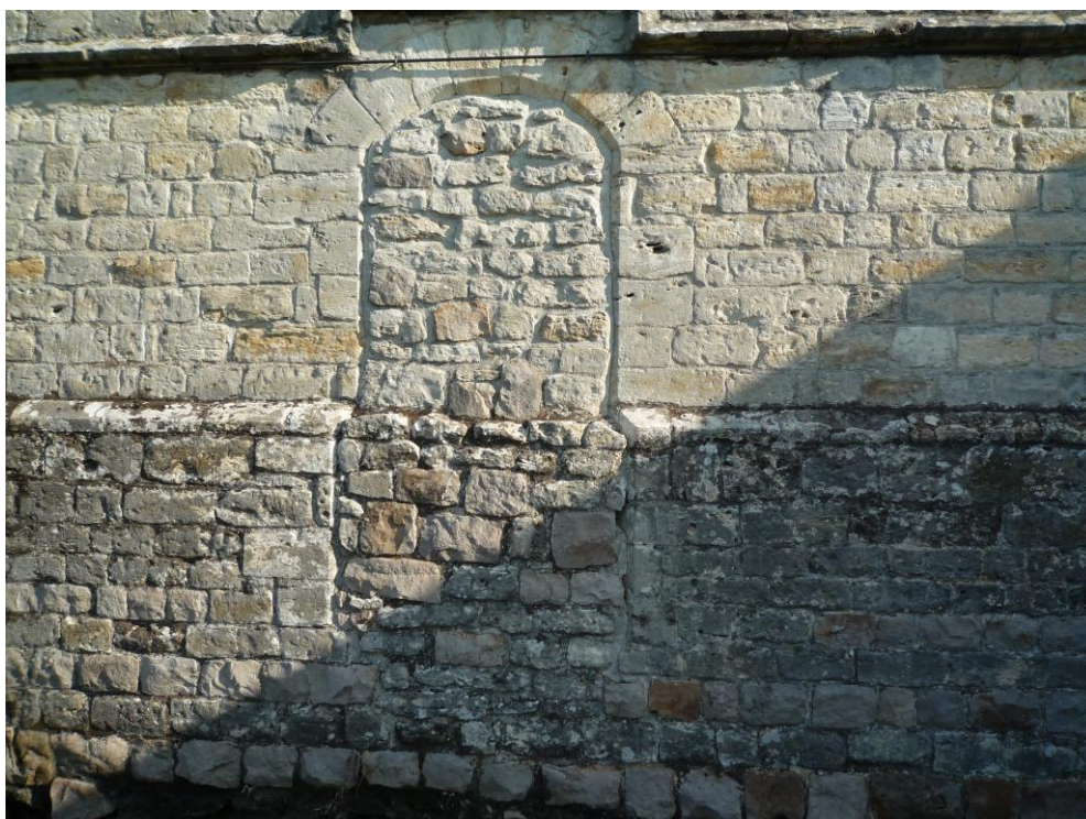
Toegemetste deur aan de Zuidkant van de kapel, die door de communautiteit van de Blotenberg zou gebruikt zijn als toegangsdeur in de volle middeleeuwen.
