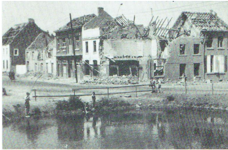
Na het opblazen van de Grote Brug (mei 1940)
