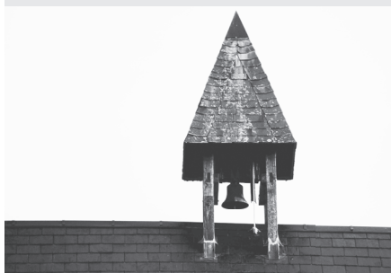
Fig.12. De dakruiter met de klok
