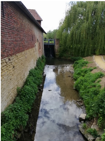
Luiwerk met houten kroonwiel van het oude mechanisme in het molengebouw
