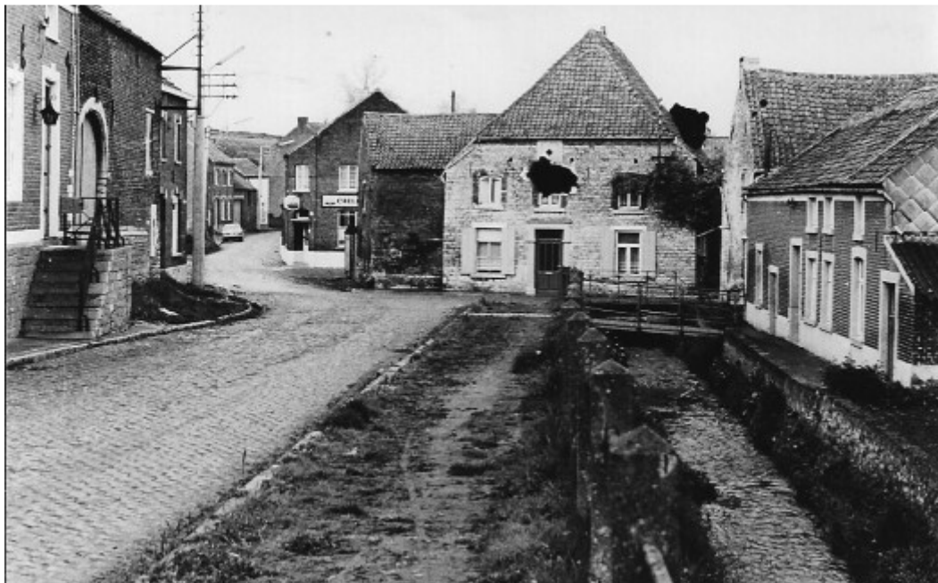
Foto vóór de verlegging van de beek
