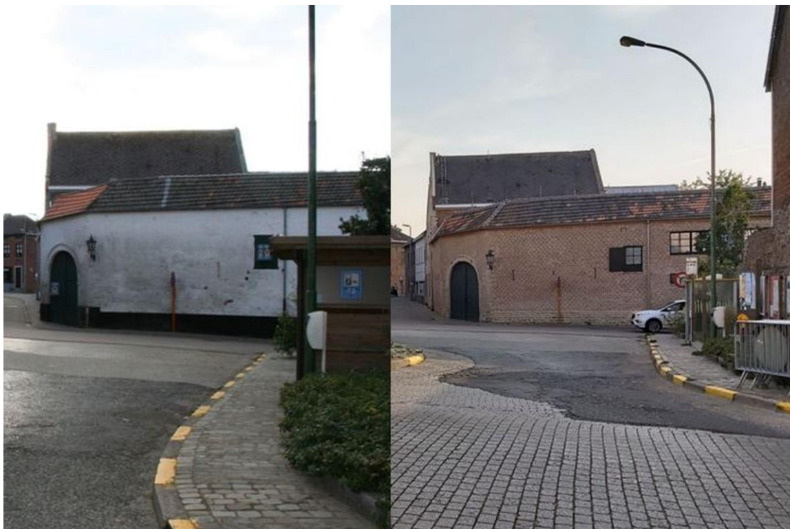
Figuur 45 De Paradijshoeve voor en na de restauratie
