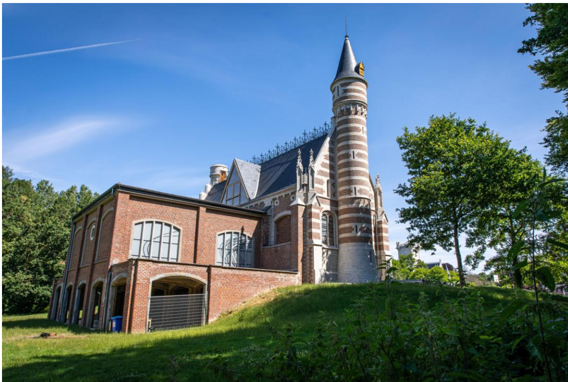
Figuur 48 De achterzijde van de orangerie
