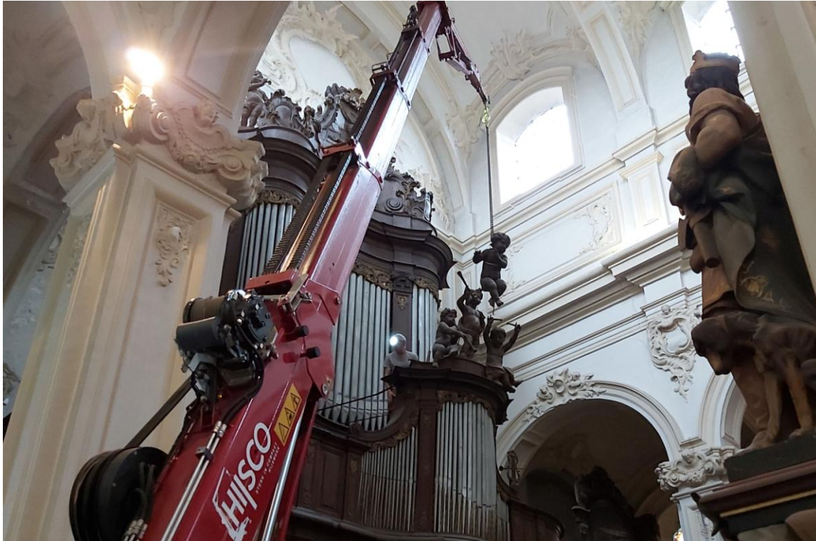
Figuur 49 De" eerste engel wordt van het doksaal verwijderd
