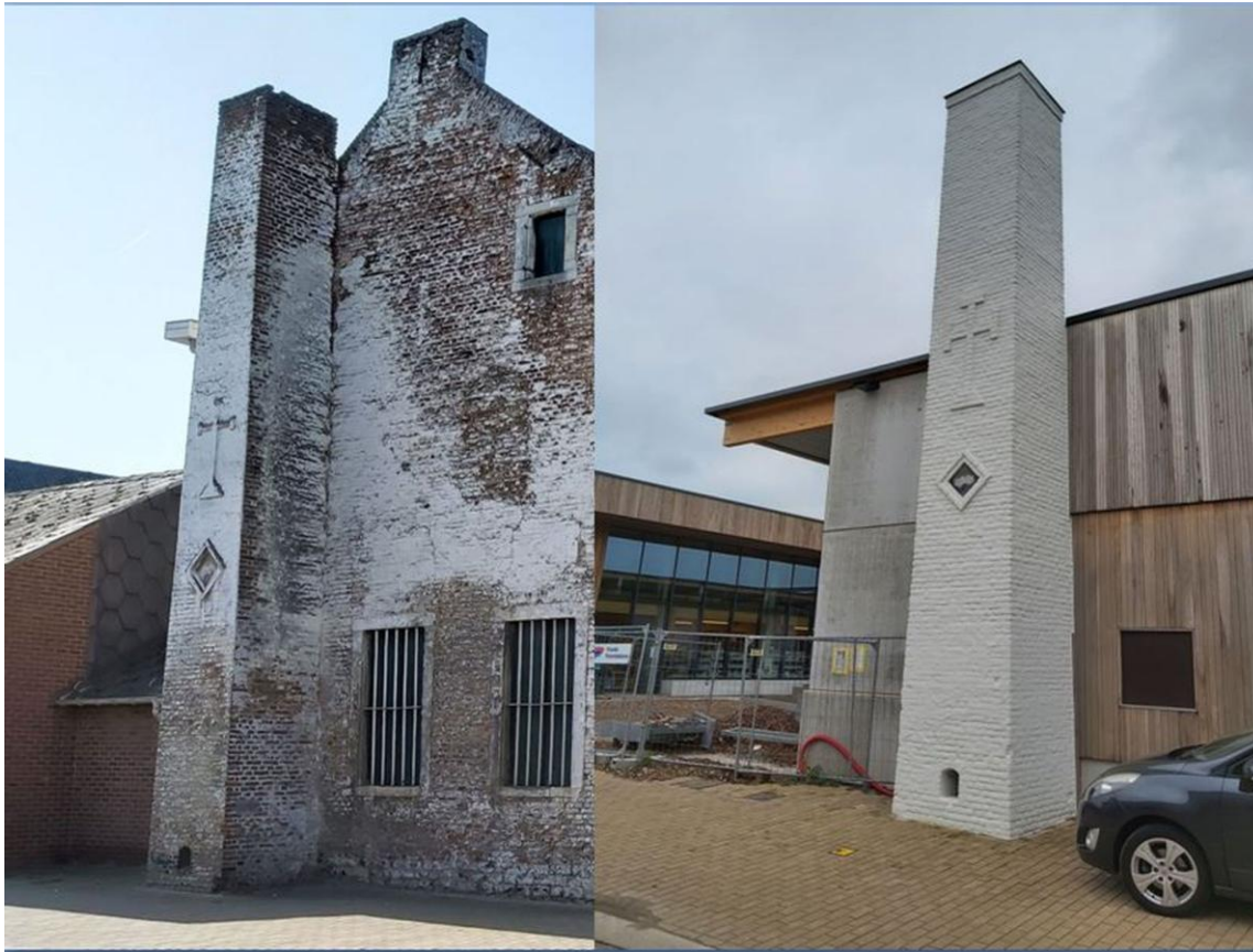
Figuur 15 De schoorsteen voor en na de heropbouw
