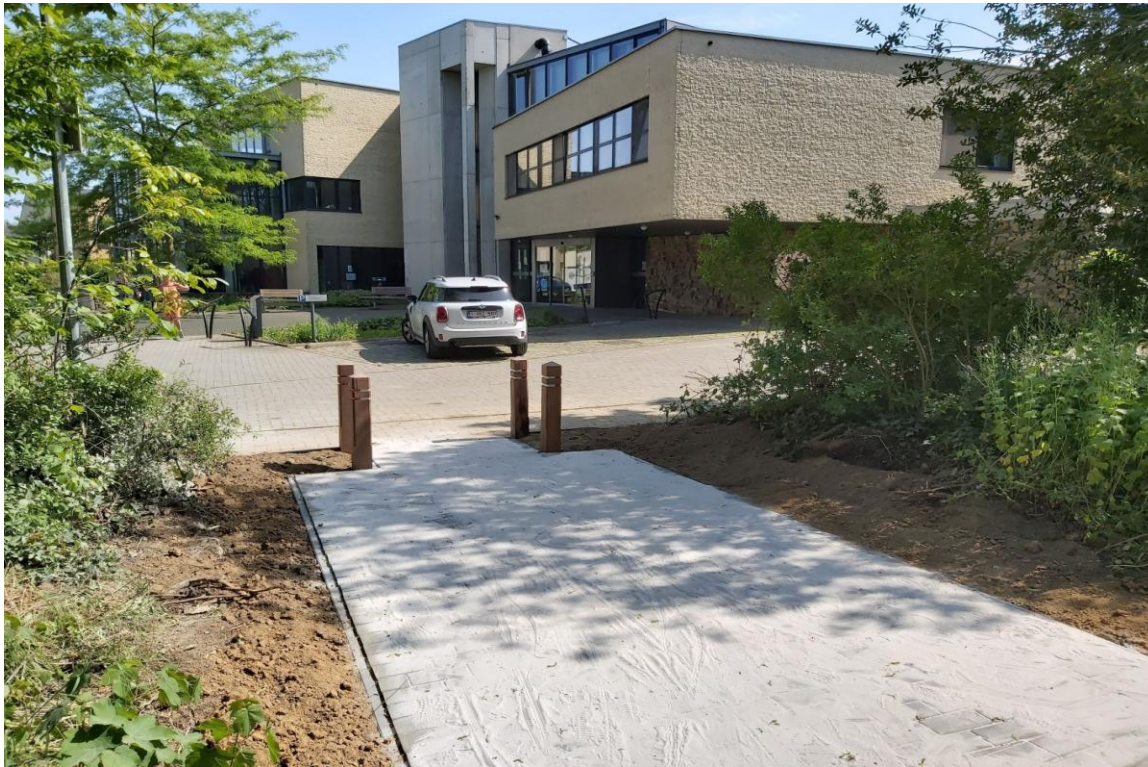
Figuur 13 Een nieuwe ingang van het Park ter hoogte van Villa Hugardis
