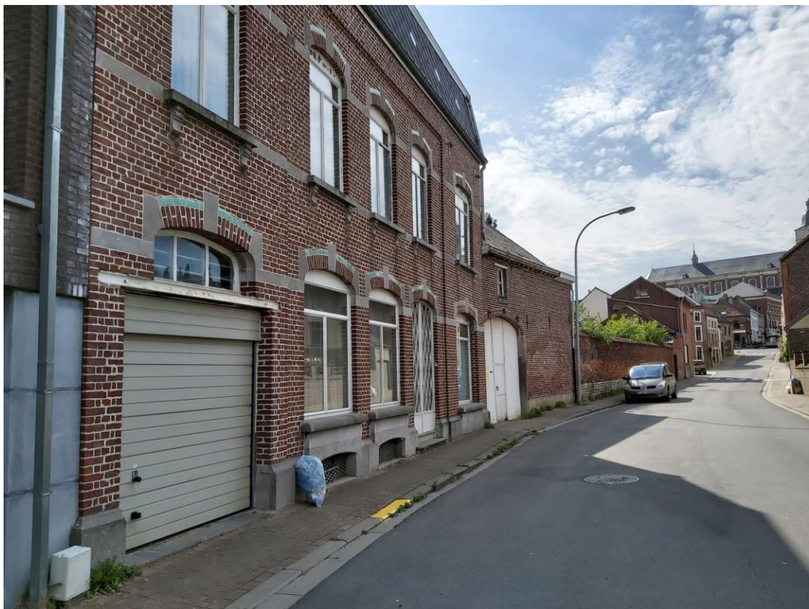
Figuur 18 De aanvraag voor de bouw van 20 appartementen in de Gasthuisstraat zou veel stof doen opwaaien
