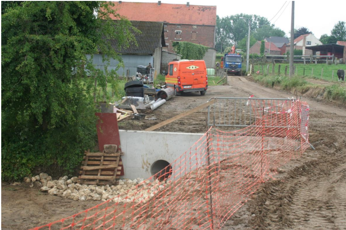
Figuur 25 Rioleringswerken aan de Kapittelbergstraat in Hoxem
