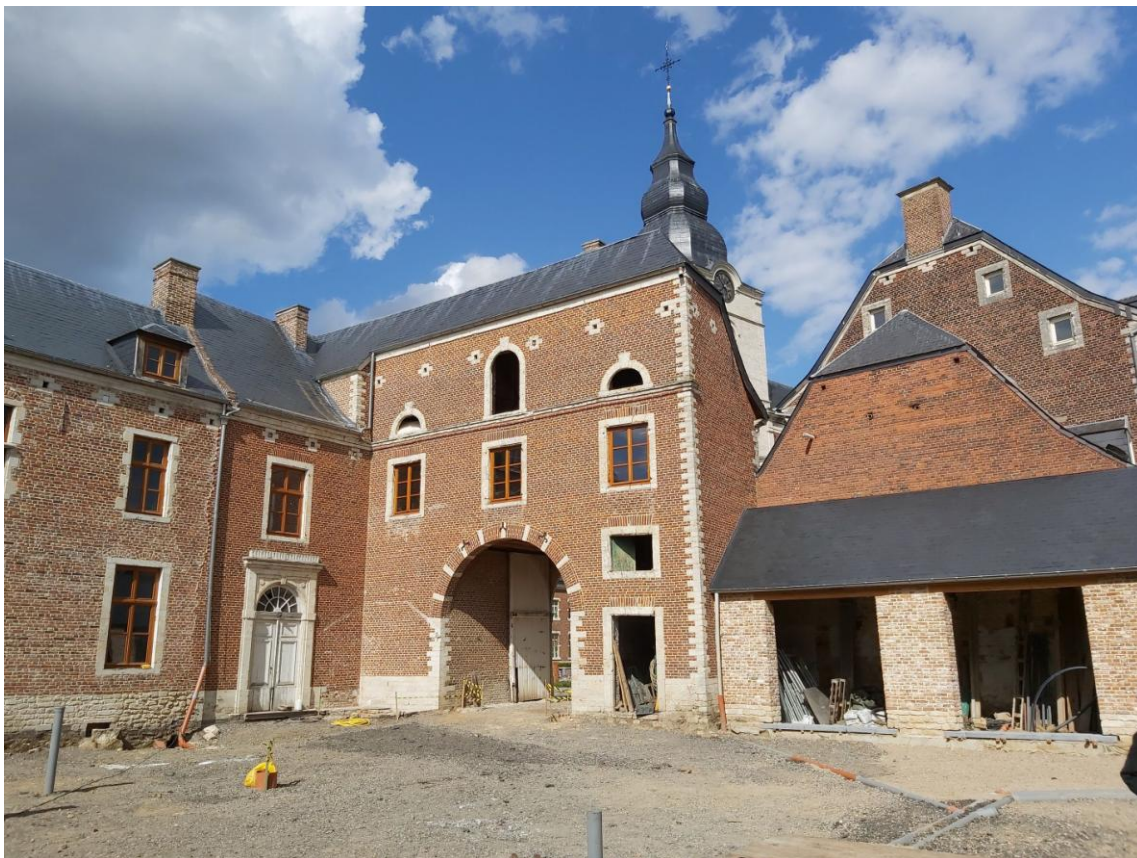
Figuur 37 Het Arendsnest of de kapittelhoeve tijdens de restauratie
