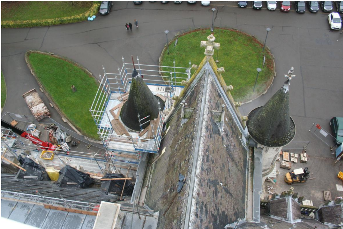
Figuur 54 Het kasteel van Meldert tijdens de restauratie: bovenaanzicht van op de toren
