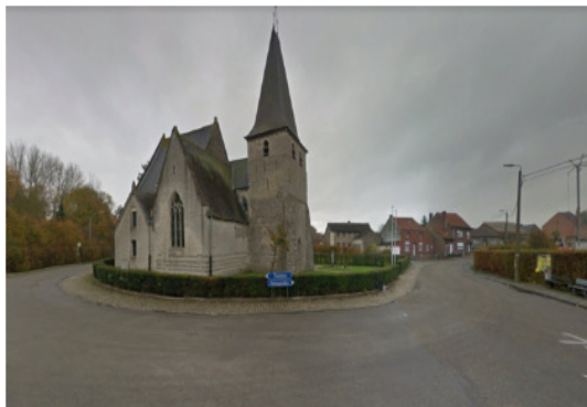
■ Zowel de Sint-Jansstraat (links) als de Bronstraat (rechts) vallen binnen het project. (FOTO: GOOGLESTREETVIEW)
