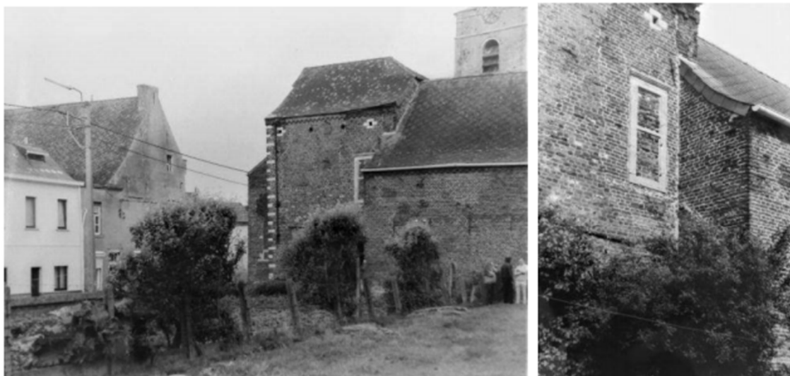
Afbeeldingen 2.26 en 2.27. Buitengevels van enkele gebouwen van het hoevecomplex Arendsnest. Deze gevels vormen de westelijke grens van het als dorpsgezicht beschermde gebied. Rechts de stallen van de hoeve, links loopt de Walstraat, mei 1985.
