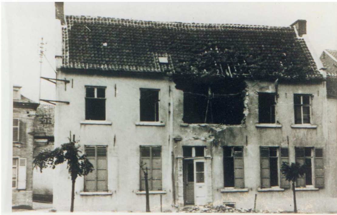
Huis Haumont, recht over de kerk, tijdens de afbraak voor aanleg rondpunt Houtmarkt
