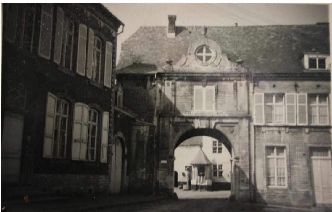
Open ingangspoort van het Arendsneest (boven) met zicht op de overdekte waterput
