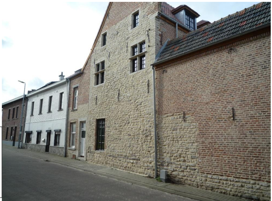
De gerestaureerde gevel aan de Walenstraat
